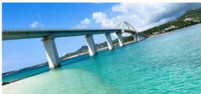
国頭郡本部町の瀬底大橋
